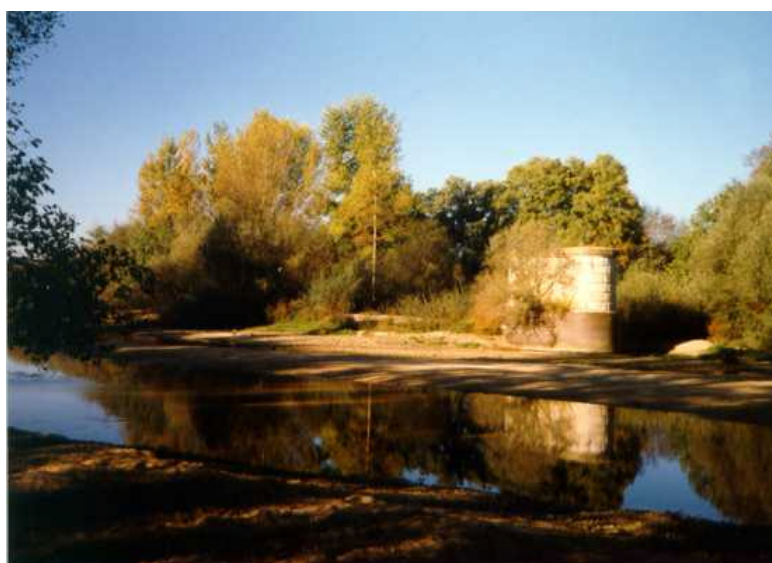
Foto 2: Restos del puente del Ferrocarril Madrid-Almorox sobre el río Alberche
