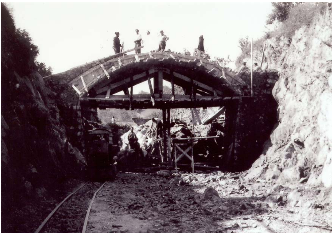
Presos del destacamento de Bermeo trabajando bajo la atenta vigilancia de la Guardia Civil. Archivo del Museo Vasco del Ferrocarril
