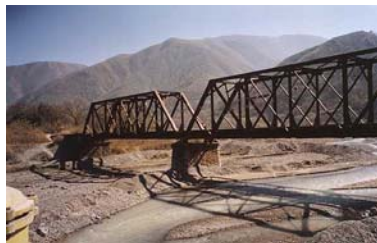
Puente metálico Río Blanco (Salta)
