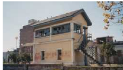
Cabina de señales (Tucumán)
