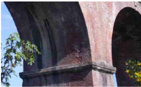
Figura Nº 7. Imposta o Cornisa, realizada en hormigón. Fuente: fotografía de los autores.
