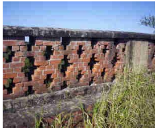
Figura N° 13. Baranda de ladrillo con pasamanos de granito natural. Fuente: fotografía de los autores.
