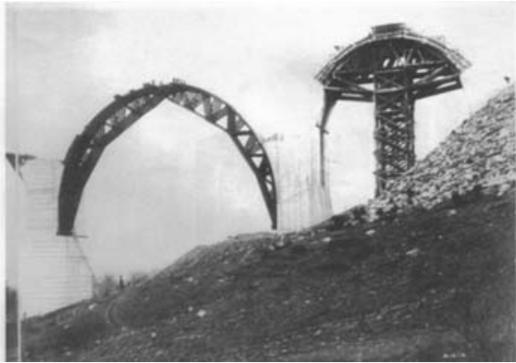
Figura Nº 6. Sistemas de cimbras de cornisa y de apoyo central. Fuente: www.brantacan.co.uk-archseven.htm . (Foto en B y N)
