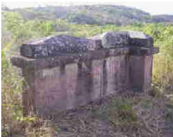
Figura N° 12. Muretes de los estribos. Fuente: fotografía de los autores.
