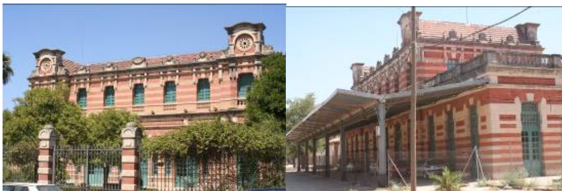
Figura nº8: Edificio de viajeros rehabilitado y marquesina 1999-2002. (Escuela Taller “Industria y Paisaje” de Linares.
