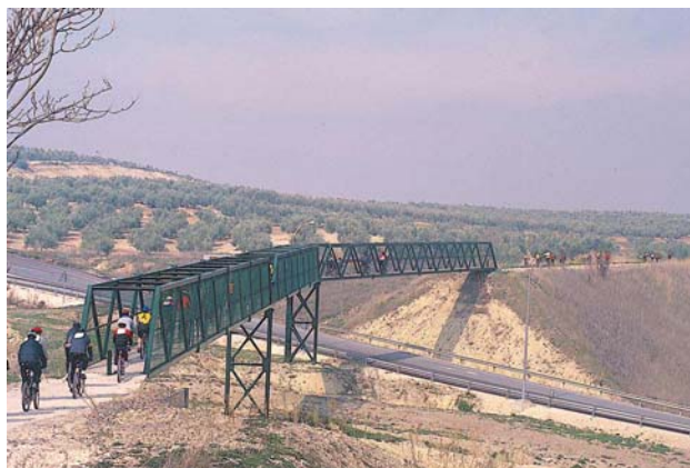
Fig. 7. Vía Verde del Aceite, donde se han construido seguras pasarelas sobre las carreteras. Foto: Fundación de los Ferrocarriles Españoles
