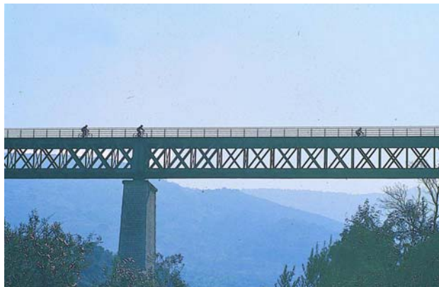
Fig. 6. La Vía Verde del Aceite y sus imponentes viaductos permiten atravesar el Parque Natural de la Subbética. Foto: Fundación de los Ferrocarriles Españoles.
