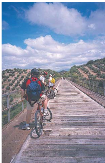
Fig. 13. Viaducto del siglo XIX en la Vía Verde del Aceite rehabilitado ara el paso de ciclistas y caminantes. Foto: Fundación de los Ferrocarriles Españoles
