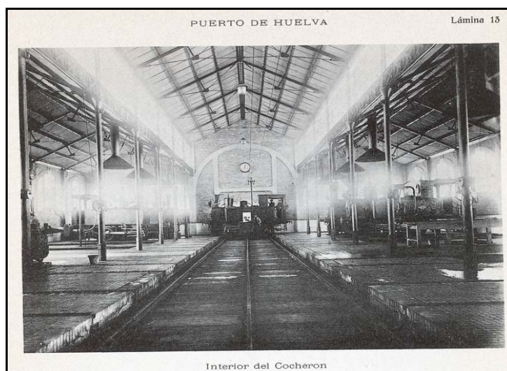
Fotografía 6.- Interior de la Cochera de locomotoras (A.P.H.)
