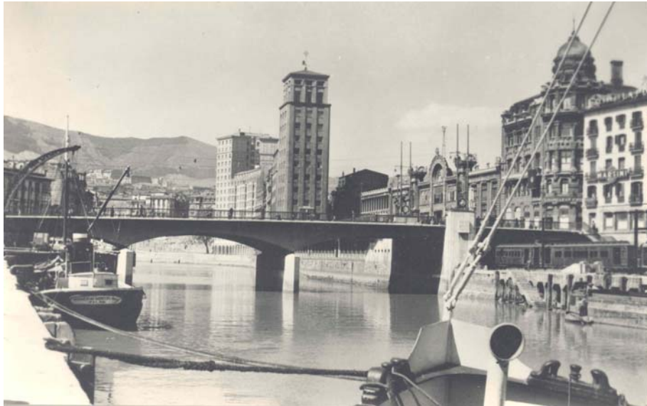
Puente del Arenal, apeadero de la Naja y edificio de la S.A. Olaveaga en Bilbao Bizkaiko Foru Aldundia- Foru Artxiboa /Diputación Foral de Bizkaia- Archivo Foral
