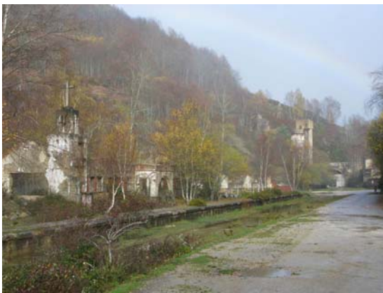
Estación de La Engaña (Burgos). Detalle de la boca sur del túnel (6.976 m de longitud), y restos de la capilla-escuela construida en 1954 para los trabajadores.
