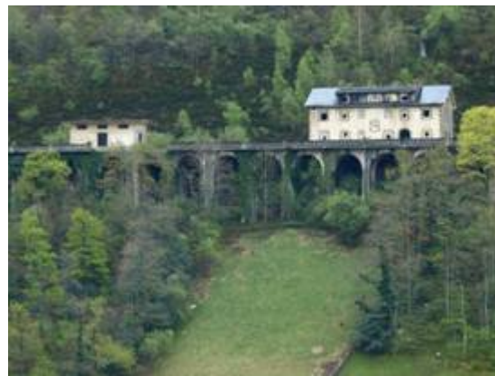
Estación de Yera (Cantabria). La falta de espacio a la salida de la boca norte del túnel de La Engaña obligó a construir una plataforma de sustentación para la estación.
