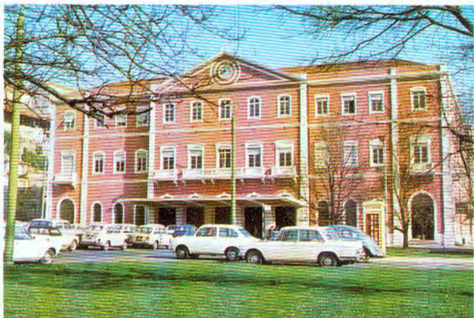
Estación de Santa Apolonia
