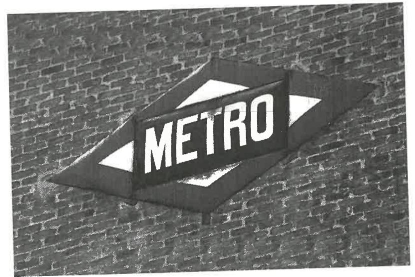
Rombo metálico de cinco piezas; el de mayor tamaño conocido: 2 x 1 ms Fachada norte. Edificio "Casa Tuduri" (demolido). Cocheras de Cuatro Caminos Foto del autor
