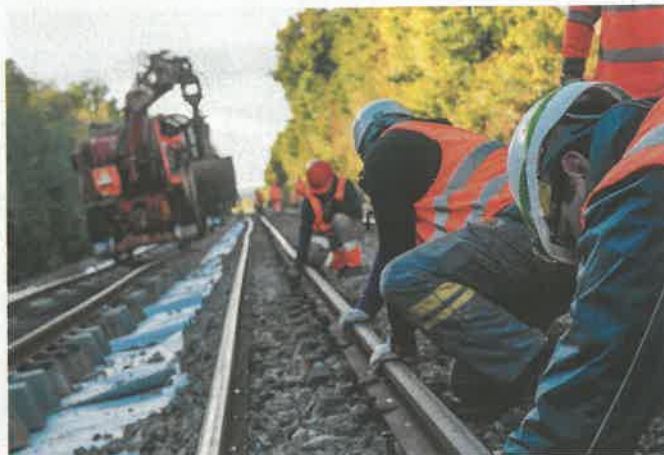
Chantier sur la ligne Perpignan - Villefranche-de-Conflent.
