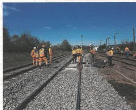
Travaux de remplacement d'appareils de voie.
