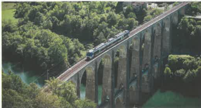
©SNCF Réseau_Capa Pictures_Lionel Flusin
