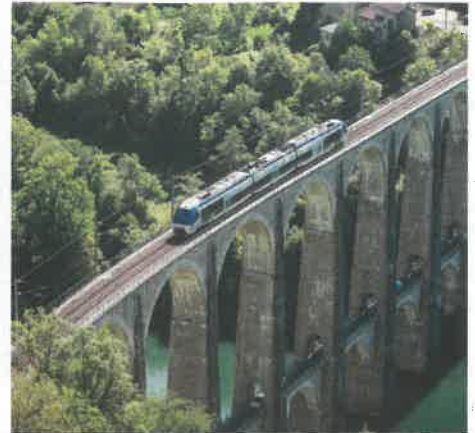
©SNCF Réseau_Capa Pictures_Lionel Flusin
