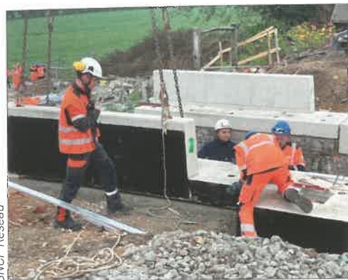
Le remplacement de l'ouvrage de Feuquières est en cours, avec ici la préparation des appuis pour le nouveau tablier (1 er novembre 2024).
