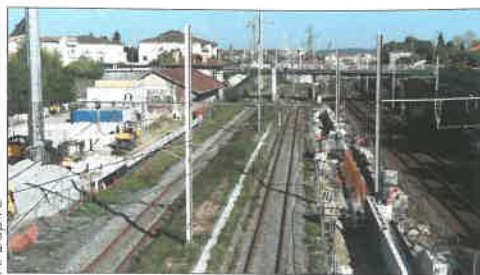
Les travaux ont commencé en gare de Talence-Médoquine (1 er novembre 2024).
